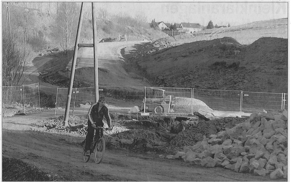
Crossfahrer sind schon unterwegs: Die Trasse der neuen Ortsumgehung zieht sich bereits die Anhöhe hinauf. (Foto: Ising)
