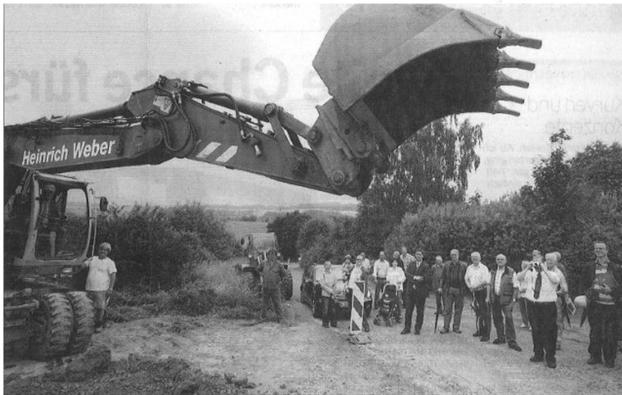
Als hätte er nie etwas anderes gemacht: Bürgermeister Bernd Hombach baggerte den ersten „Spatenstich“ höchstpersönlich. (Foto: Ising)
