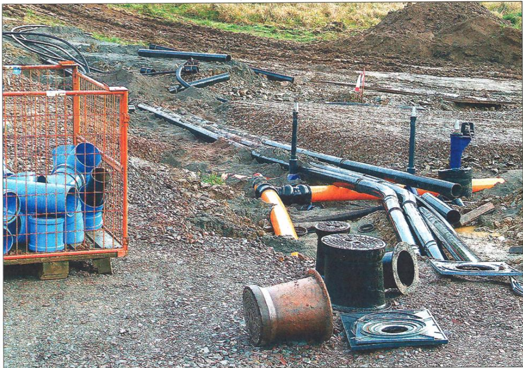
Die Erschließungsarbeiten im Bereich des künftigen Wohngebiets Werlsiepen sind weit fortgeschritten. So sind zum Beispiel schon die Versorgungsleitungen verlegt und die Baustraßen geschottert worden. ■ Fotos: vom Hofe
